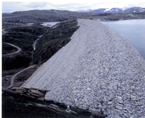
Storglomvassdammen er et ruvende byggverk i det åpne fjell-landskapet. Veien opp til parkeringsplassen på Navnløshøgda går like ved damfoten.
