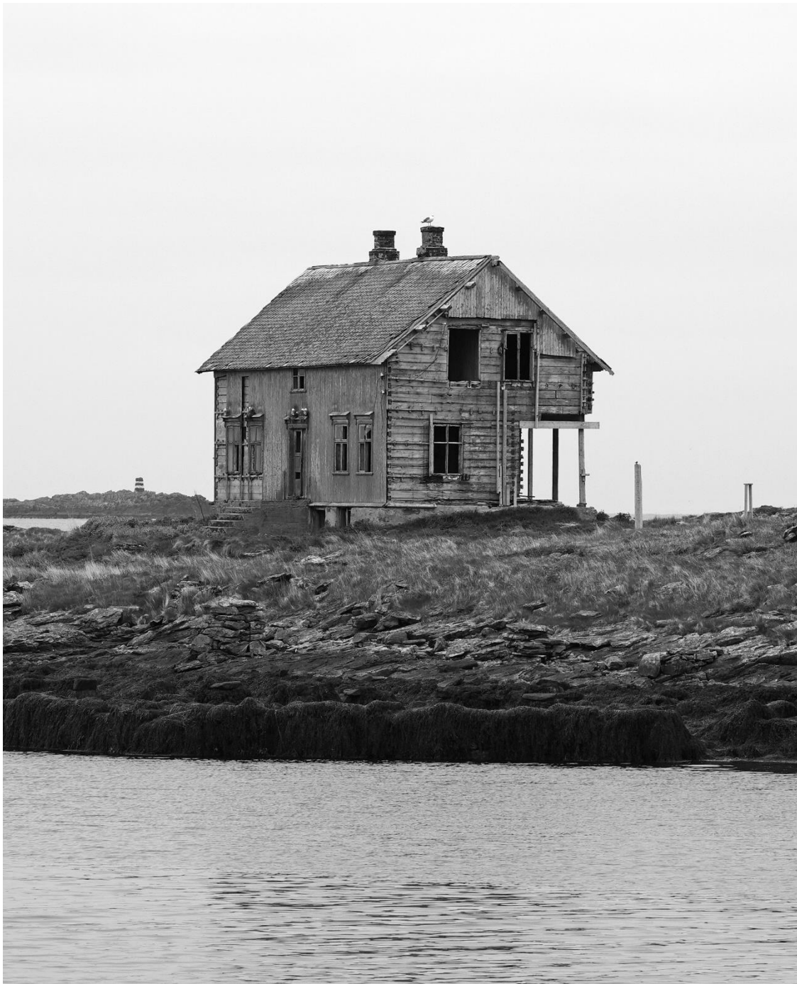
«Toralfhuset» på Røst. Det har nå blitt kjøpt av fortidsminneforeningen og skal restaureres.
